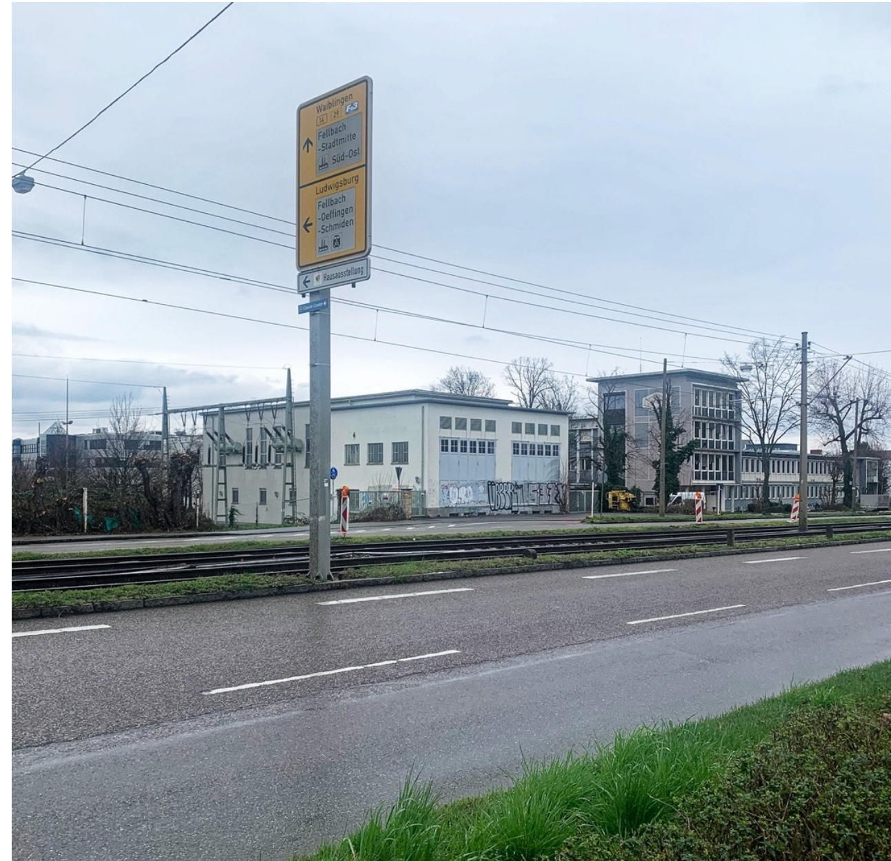
6. Blick auf das Umspannwerk von der Stuttgarter Straße aus, aus Richtung Stuttgart. Bild: IBA'27, G. Adamczyk-Arns
